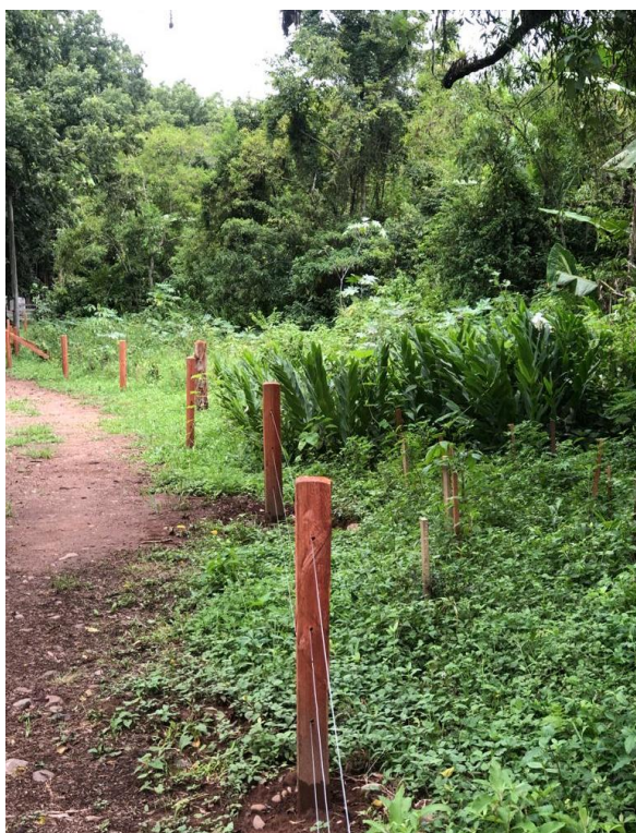
Figura 23: Cercamento da área realizado pela equipe da Prefeitura Municipal de Maquiné
