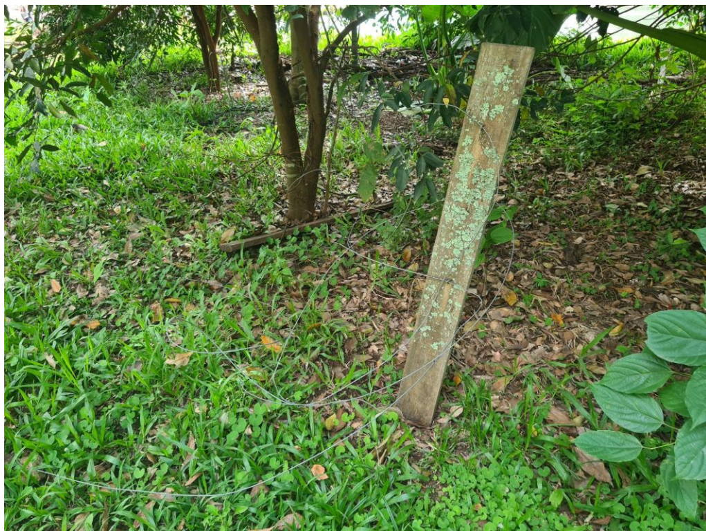
Fig. 5: cerca com sinais de depredação. 25/out/2022
