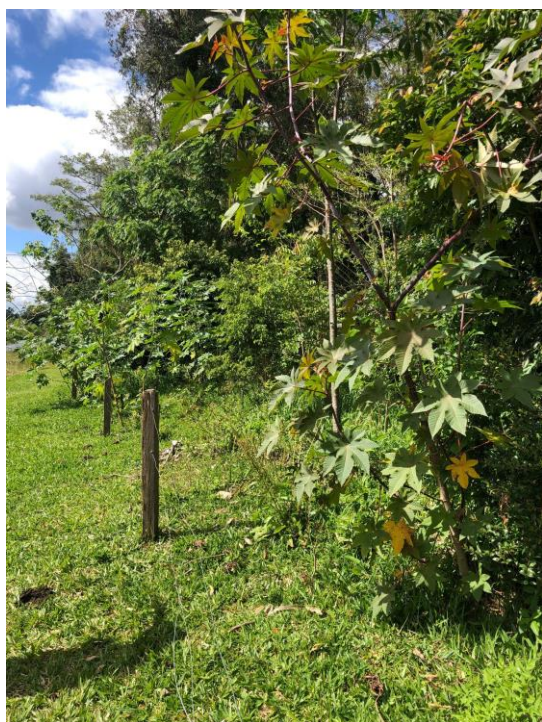
Fig. 17: cercamento deteriorado na margem do rio Maquiné. 25/out/2022
